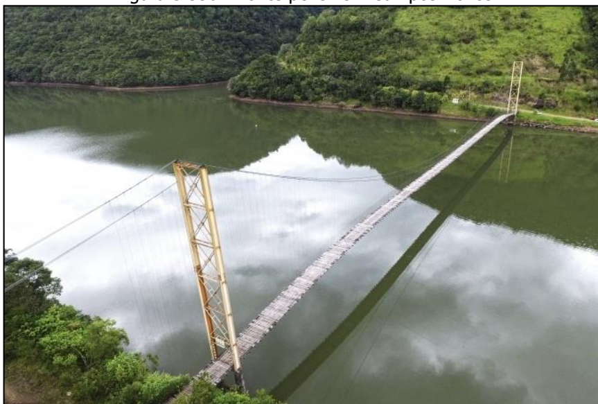
Figura 5.356 - Ponte pênsil em Campos Novos
