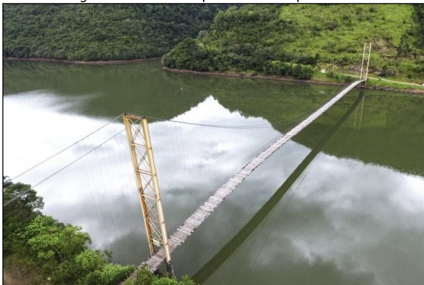
Figura 5.356 - Ponte pênsil em Campos Novos
